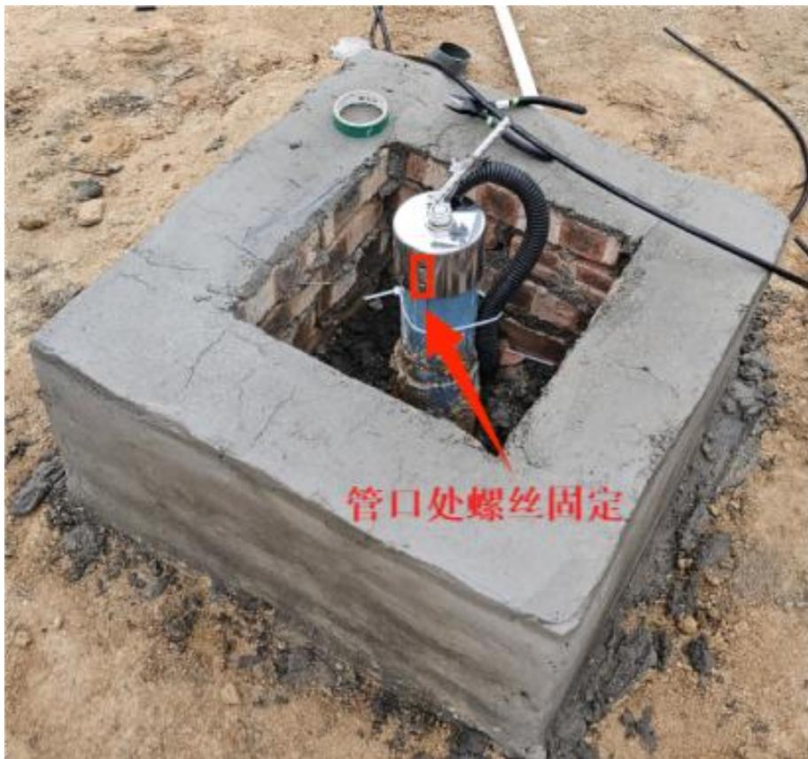
步骤 4：固定式测斜仪安装完毕后，有条件或现场容易遭到破坏的情况，在测斜管周围下挖 10 公分作为基础，搭建 40\*40cm 围挡保护测斜仪，围挡高度不得低于测斜管露出地表的高度，最后再做一块水泥上盖盖在上面。
