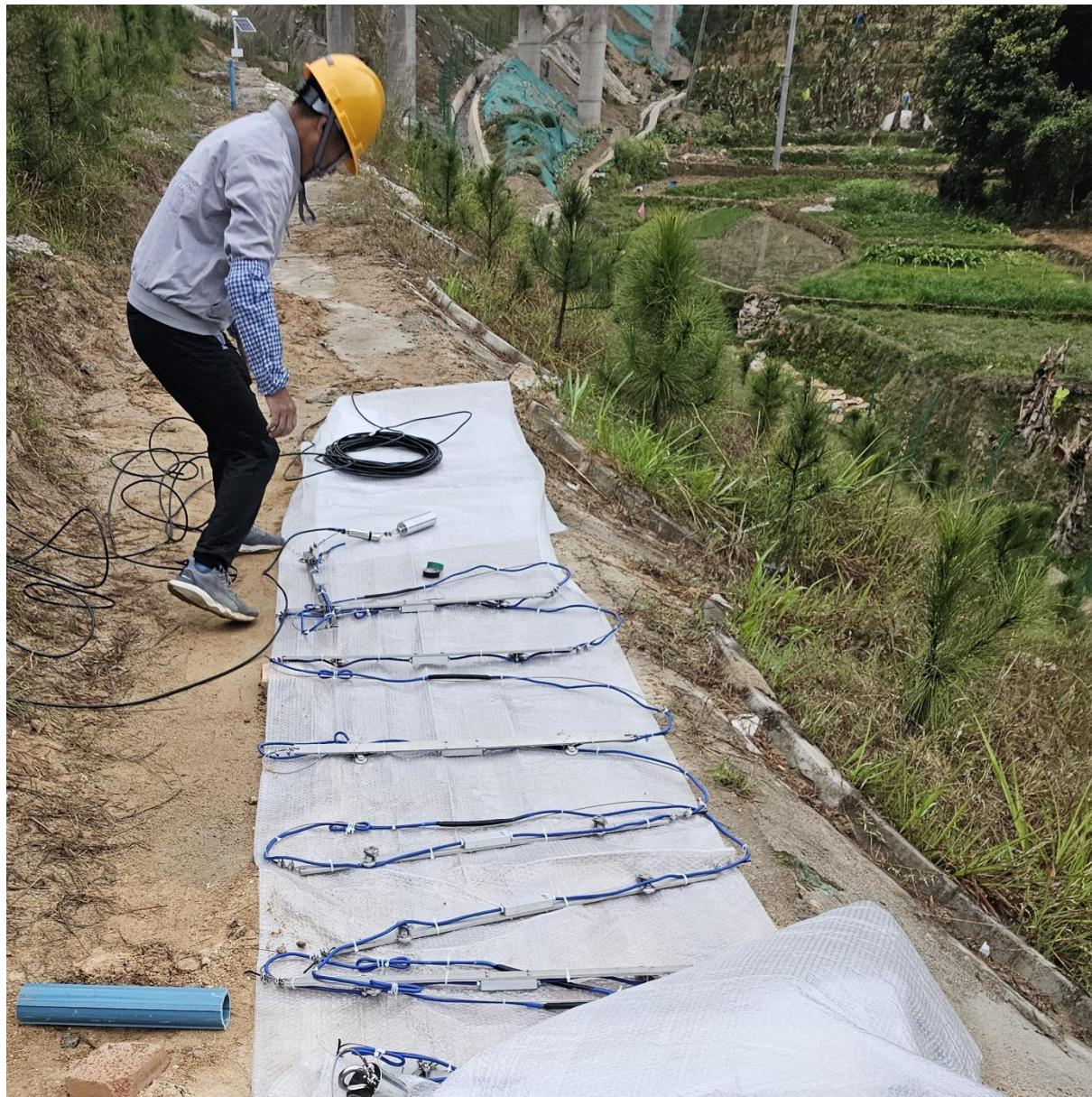
步骤 2：先下放尾部配重，并在下放过程中检查是否下放顺畅，确保不被卡住，然后将固定式测斜仪每节导轮按顺序沿测斜管卡槽方向下放。
