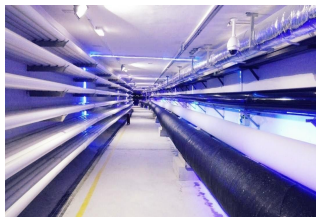
城市综合管廊
