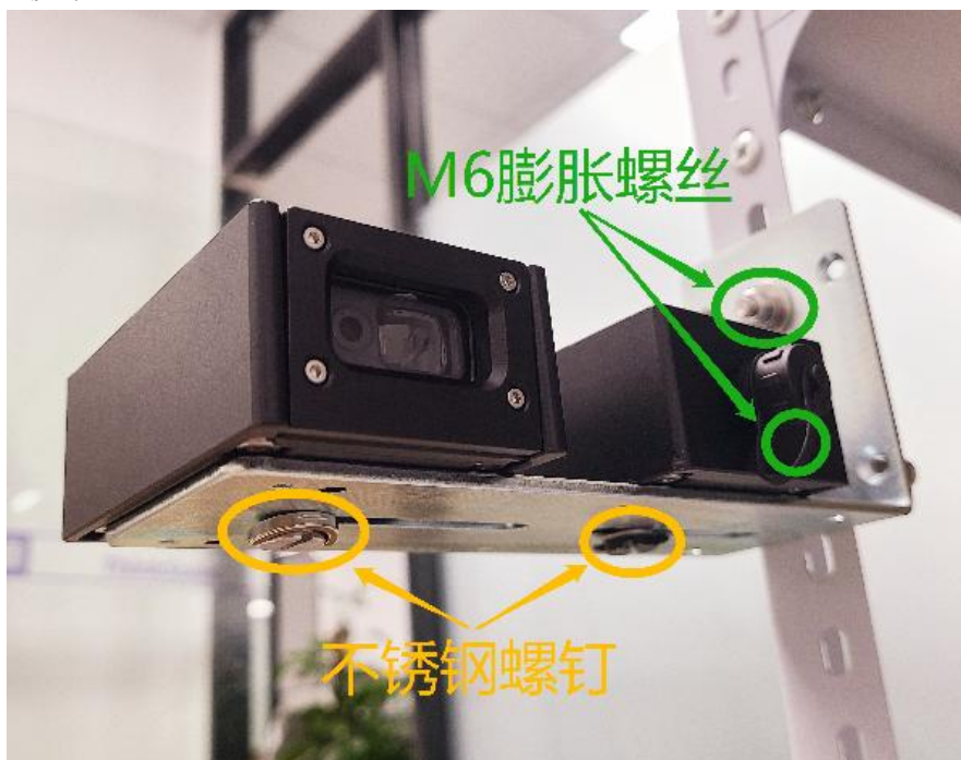
□ 支架III模拟现场安装图二：
