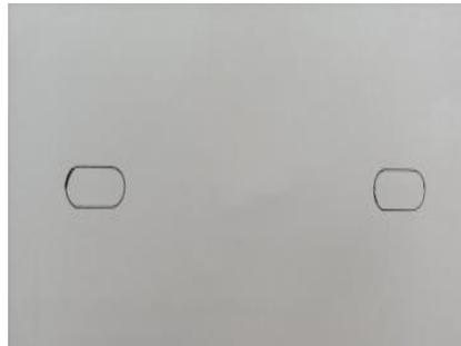
4) 用电钻把标记位置的地方钻出两个孔，以便安装支架时锁住螺丝。（建议打孔时往标记位置的中间打，以免打偏）
