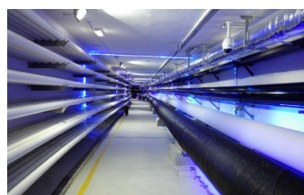
综合管廊沉降监测
