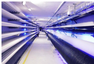
城市综合管廊
